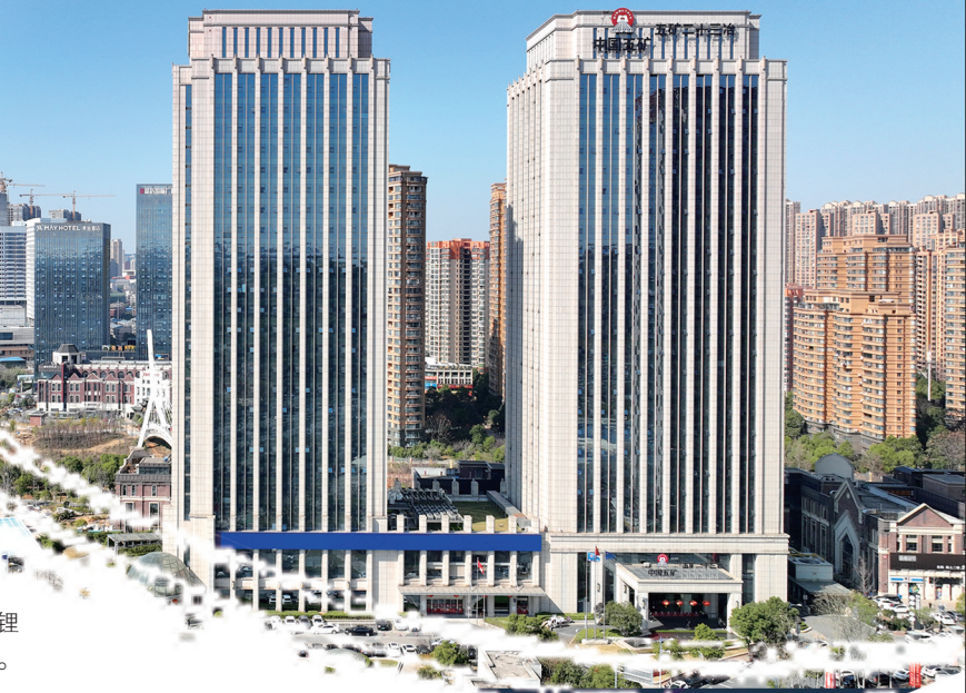
五矿二十三冶总部大楼航拍图。
