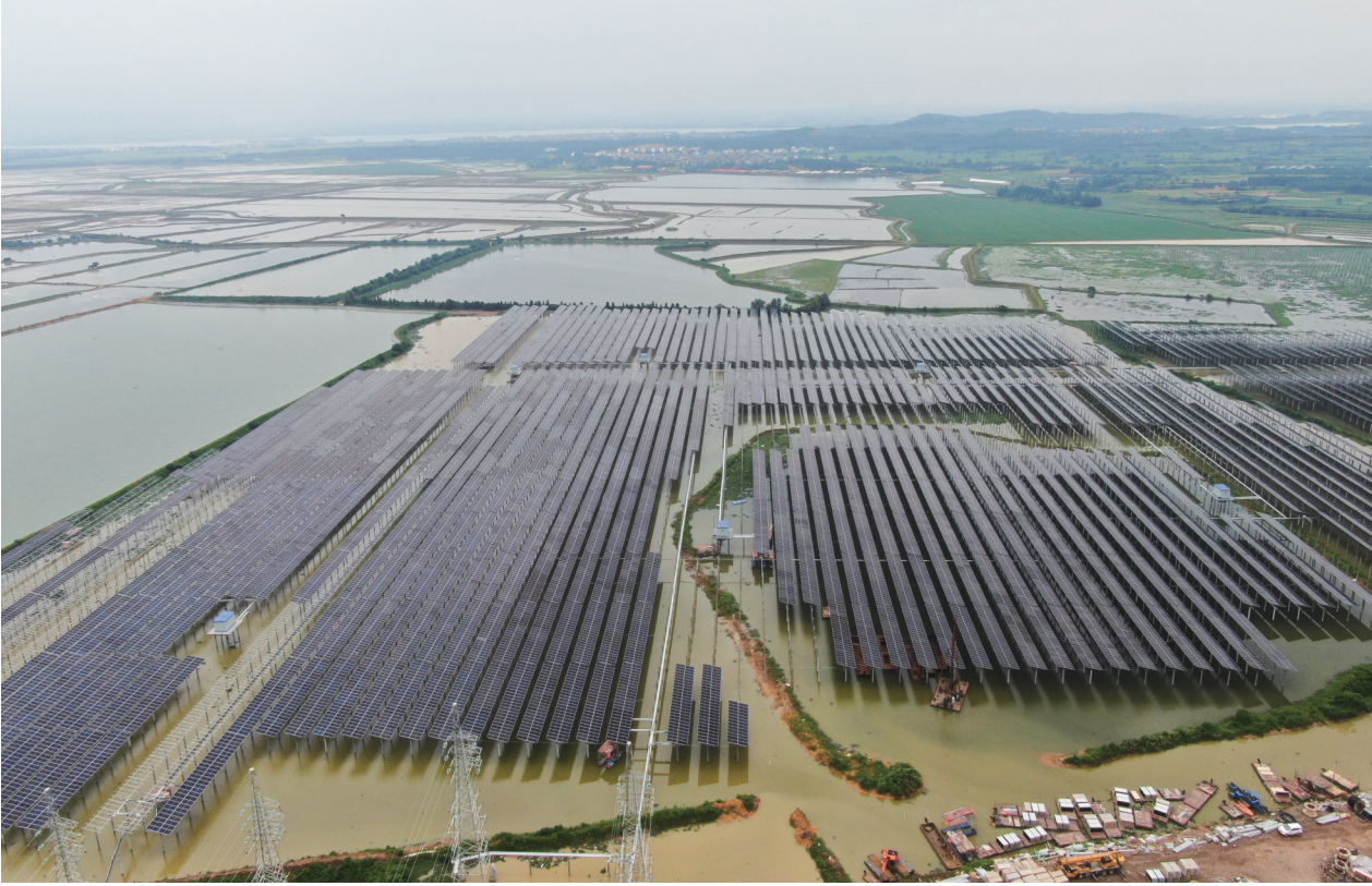
从娄底经开区大埠桥街道中阳村走出的企业——湖南湘江电力集团承建的水上光伏项目。
