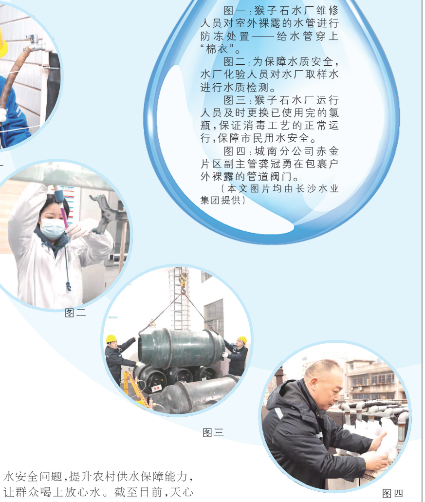
图四:城南分公司赤金片区副主管龚冠勇在包裹户外裸露的管道阀门。(本文图片均由长沙水业集团提供)
