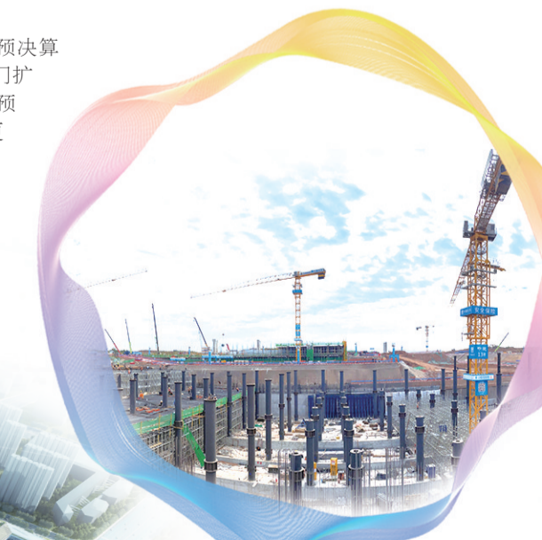
长沙机场改扩建工程现场。（湖南省机场管理集团有限公司供图）
