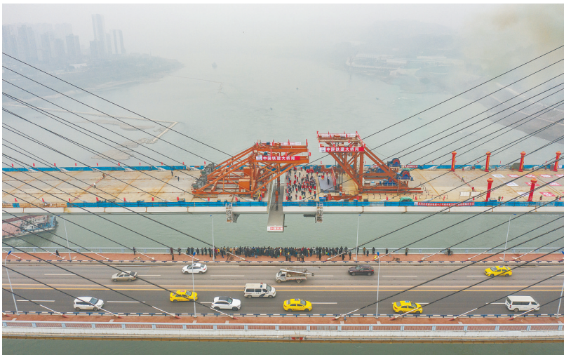
1月12日，重庆轨道交通18号线关键控制性工程——李家沱长江复线桥成功合龙。李家沱长江复线桥设计为公轨两用桥，上游侧为四车道市政道路，下游侧为城市双线轨道交通。图为李家沱长江复线桥合龙施工作业现场（1月12日摄，无人机照片）。
