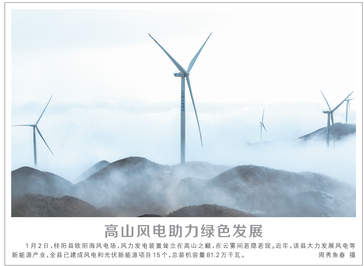
1月2日,桂阳县欧阳海风电场,风力发电装置矗立在高山之巅,在云雾间若隐若现。近年,该县大力发展风电等新能源产业,全县已建成风电和光伏新能源项目15个,总装机容量81.2万千瓦。周秀鱼春 摄
