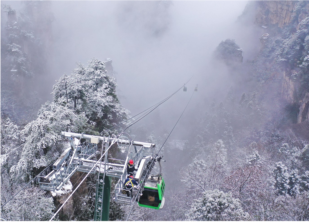
1月2日，张家界武陵源景区杨家界索道工作人员在索道支架上巡检。元旦假期，该景区出现低温冰雪天气，当地旅游管理部门对景区内高空客运索道进行安全隐患排查，确保游客安全。
