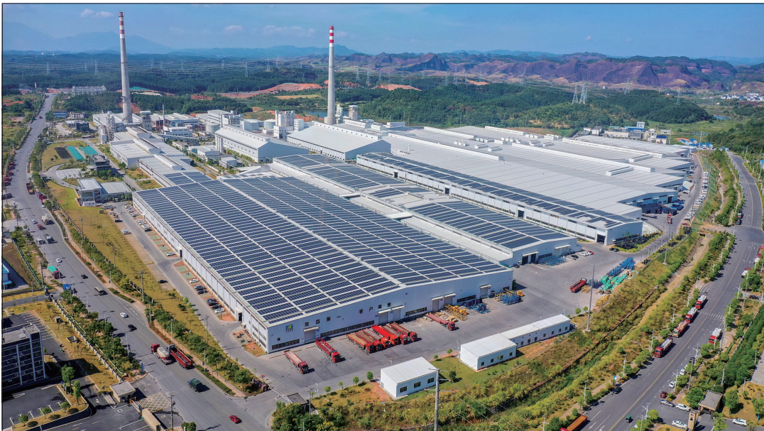
航拍资兴经开区资五产业园的郴州旗滨光伏光电玻璃有限公司。
