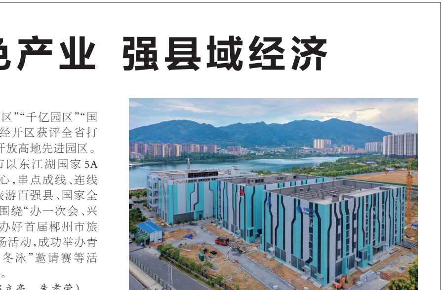
正在加快建设中的资兴市东江湖大数据产业园。
