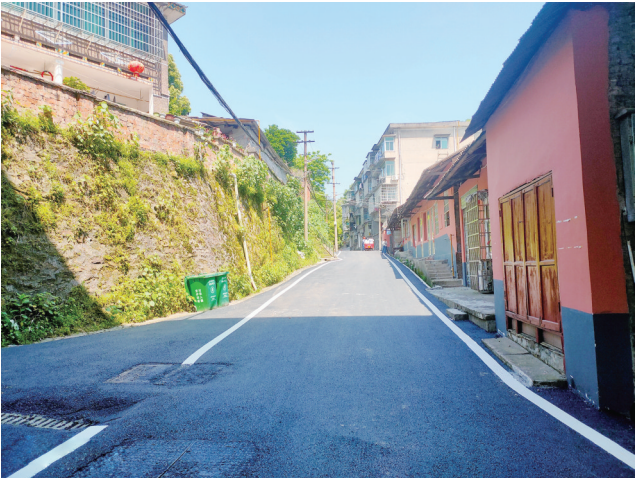
益阳市赫山区会龙山街道龙山港社区原氮肥厂老旧小区经过改造后，焕然一新。 周伟 摄
