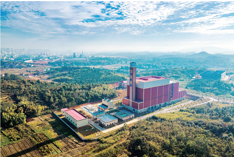
正在运行中的双峰海创生活垃圾焚烧发电厂。李建新 摄
