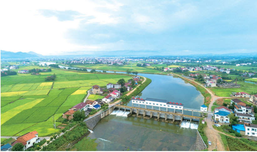
黄材水库灌区续建配套与节水改造项目实施以后，改善灌溉面积14.96万亩。（长沙市水利局供图）
