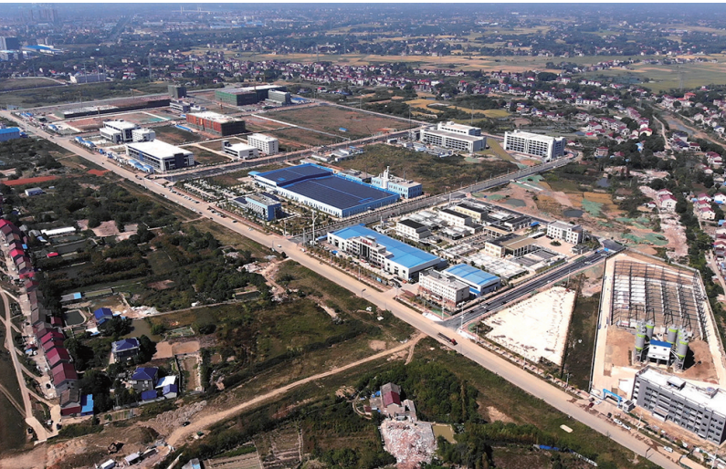
长春经开区PCB产业园(东片区)建设如火如荼展开。
