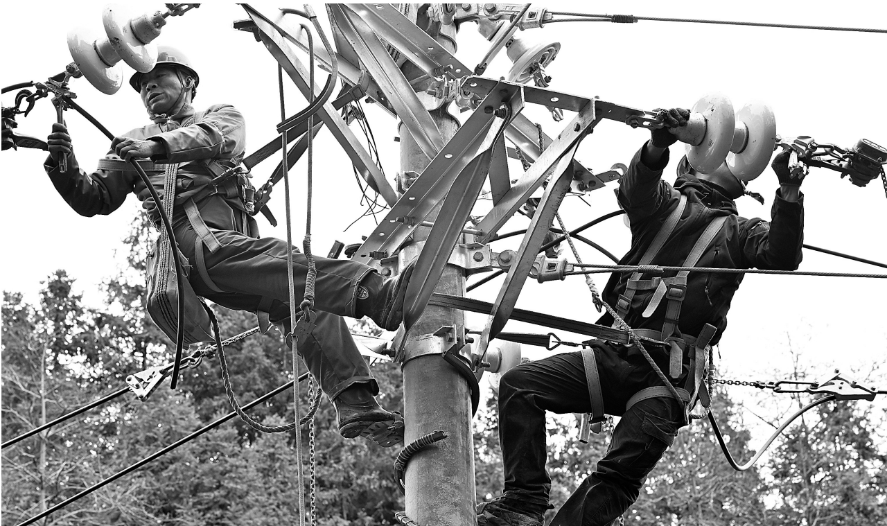
12月2日,国网隆回县供电公司电力工人冒着严寒在金石桥镇黄金井村架设新线路。今年下半年以来,该县供电部门对全县570多个村(社区)电网主干线进行升级改造,提升电网抵御冰雪灾害的能力,保障居民安全用电。贺上升 刘光平 摄影报道
