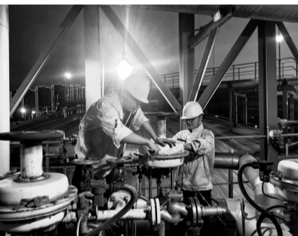
长沙新奥燃气工作人员维修气动阀。周永忠 摄
