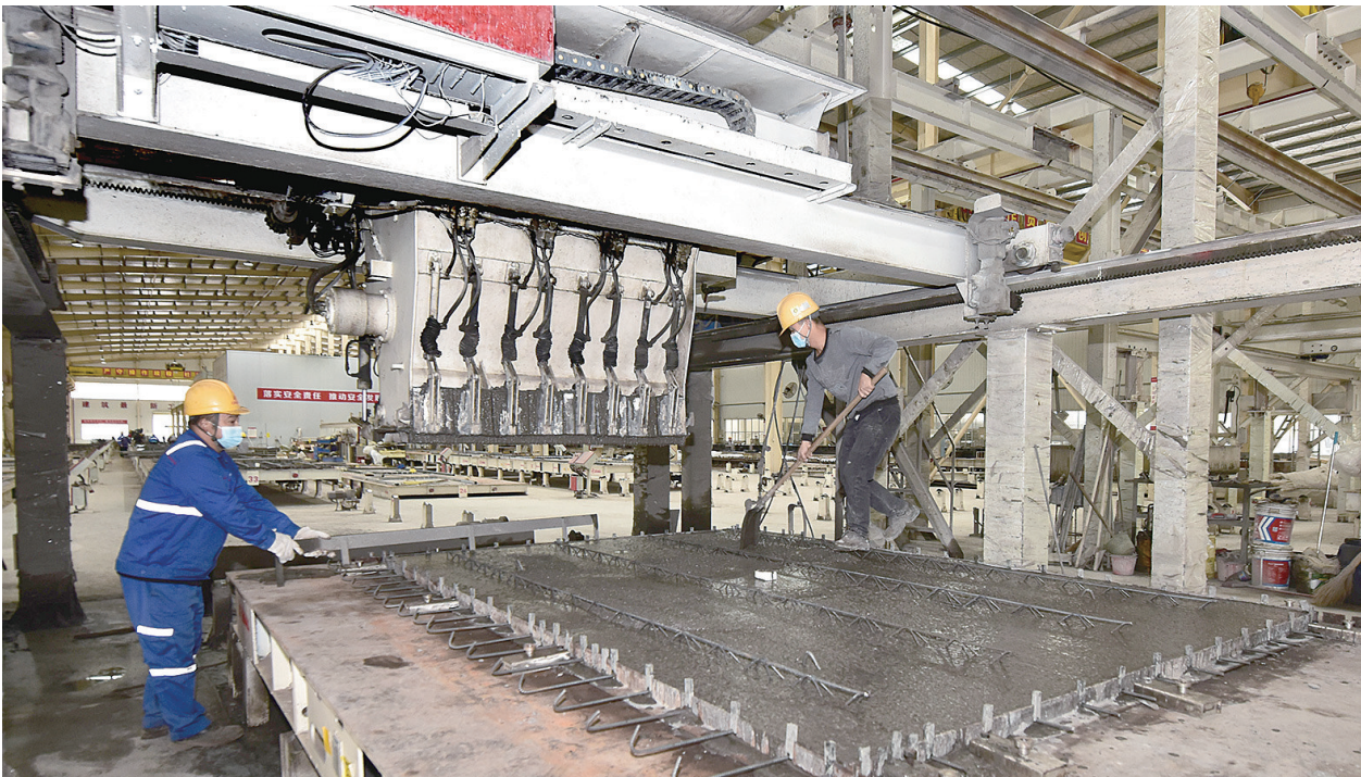
11月23日,吉首市马颈坝镇,湖南东方红住宅工业有限公司车间内,工人在进行预制钢筋水泥墙板布料施工。近年,该公司着力打造湘西装配式建筑产业园,开发具有湘西特色的装配式建筑,助推美丽湘西建设,拓展帮扶就业路,每年吸纳脱贫户50多人在家门口稳定就业,人均月收入达5000元以上。 姚方 杨燕萍 摄影报道
