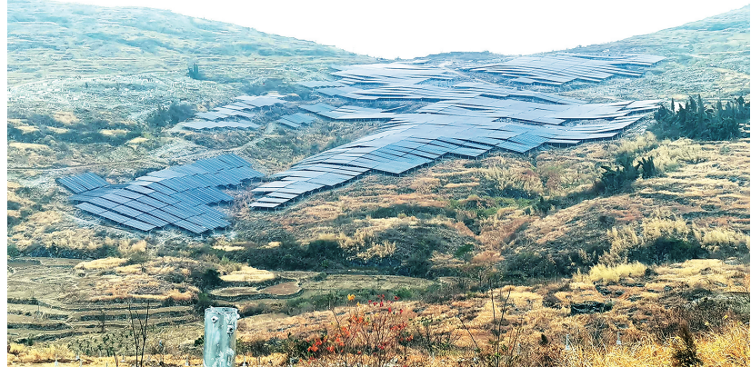
大唐华银涟源石漠化区光伏发电项目现场。童志华 摄
