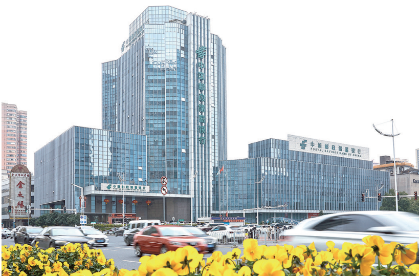
邮储银行湖南省分行大楼。（邮储银行湖南省分行办公室供图）
