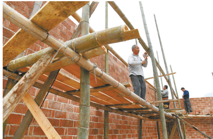
11月12日,安化县仙溪镇大溪村,一些村民正在建设文化广场。
