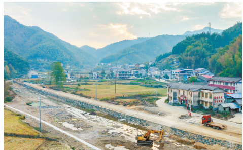
11月11日,安化县仙溪镇大溪村,新修缮的两岸河堤和河道清淤工程。 湖南日报全媒体记者 李健 摄
