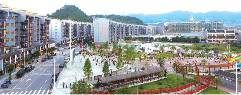
永顺县芙蓉镇易地搬迁太平安置区。
