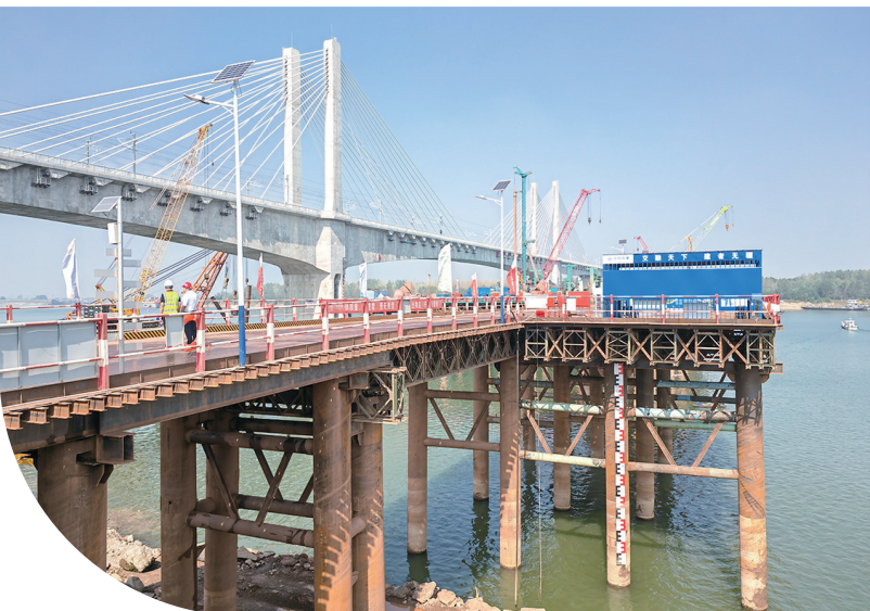
益常高速扩容工程沅水特大桥项目建设现场。鲁融冰 摄
