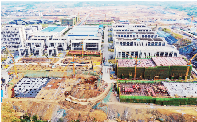
永州经开区先进装备制造产业综合体标准厂房项目建设现场。
