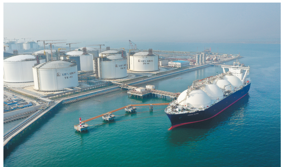
连日来,位于天津市滨海新区南港工业区的中国石化天津液化天然气(LNG)接收站码头迎来船舶接卸高峰。图为10月21日,一艘液化天然气运输船靠泊在中国石化天津LNG接收站“1号泊位”进行卸船作业。
