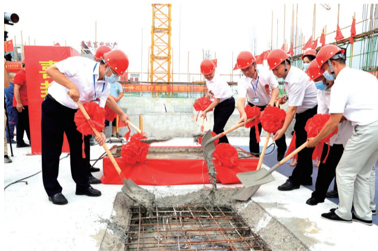
门诊综合楼和医技住院综合楼顺利封顶。
