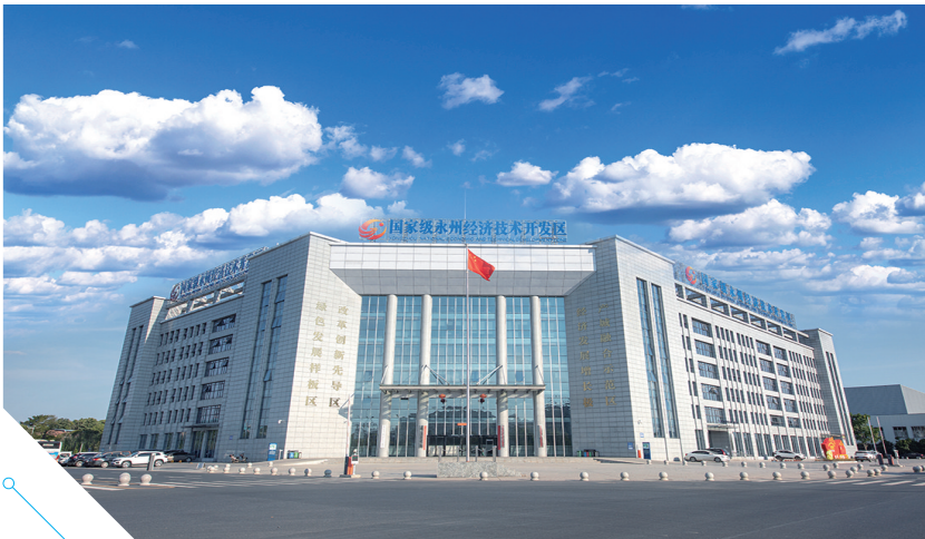
国家级永州经济技术开发区办公楼。
