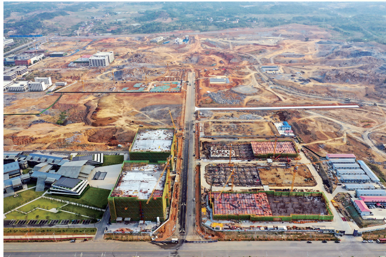
永州经开区“五好”园区核心片区项目建设现场。
