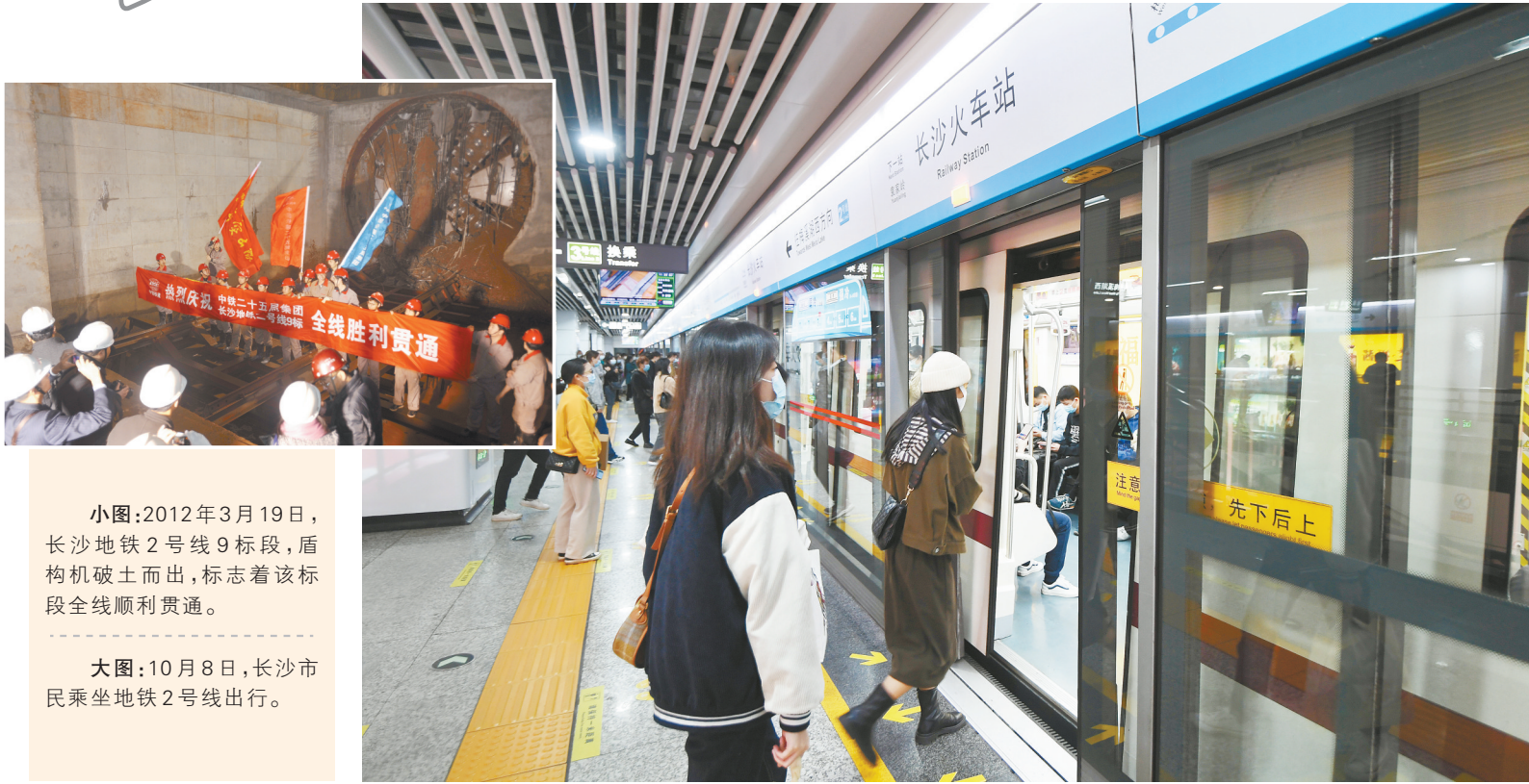
小图:2012年3月19日,长沙地铁2号线9标段,盾构机破土而出,标志着该标段全线顺利贯通。 大图:10月8日,长沙市民乘坐地铁2号线出行。
