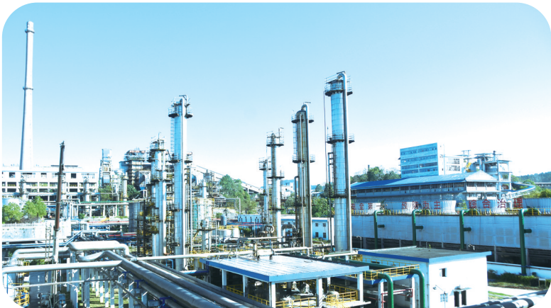
湘维公司有机车间主生产线。(本版图片由渌浦县委宣传部提供)
