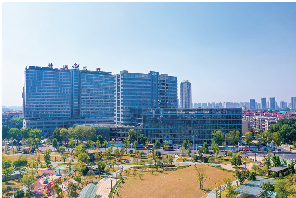
常德市第一人民医院急救中心妇儿中心综合大楼项目建设正酣，建成后将大解决“床位”问题。
