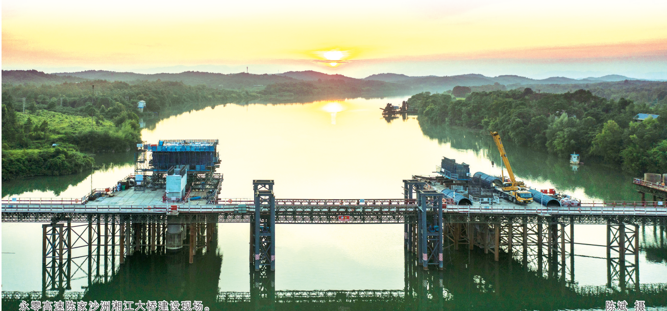
永零高速陈家沙洲湘江大桥建设现场。
