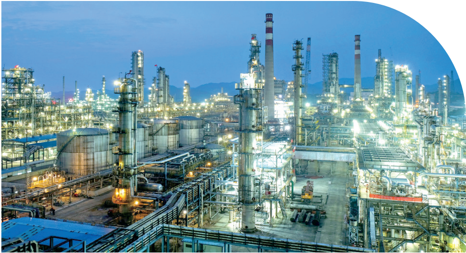
工地不夜天。(本版图片均由长岭炼化党委工作部提供)
