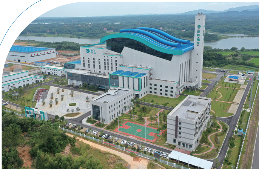
垃圾焚烧发电厂。
