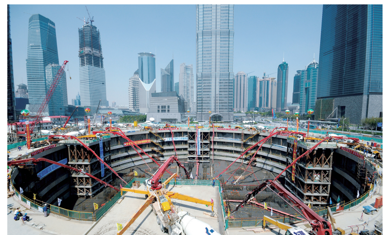
三一集团研制的系列混凝土机械产品出口110个国家和地区。图为三一集团泵送设备在“上海中心”深基坑建设施工作业。
