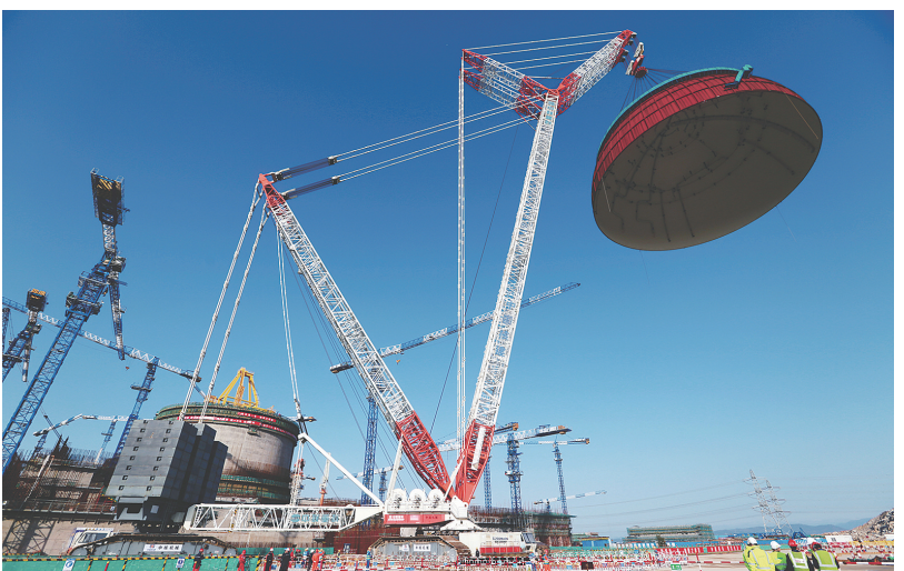
2020年7月,世界最先进的超大吨位移动式起重机——中联重科3200吨履带式起重机研发成功。图为中联重科3200吨履带式起重机正在进行“华龙一号”福清核电站穹顶吊装作业。
