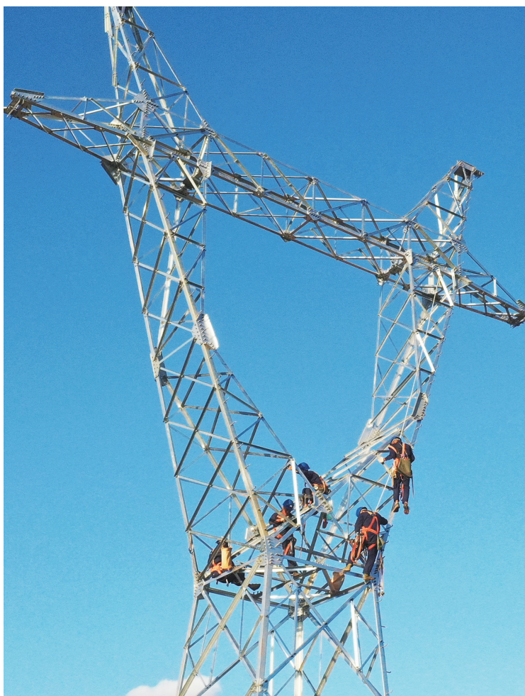
▲ 10月2日,嘉禾县行廊镇定里村,电力工人在组塔施工。国庆假期,嘉禾县(蓉城—嘉禾东)220kV线路项目工地,电力工人坚守岗位,积极推进工程建设进度,力争早日并网通电。黄春涛 摄
