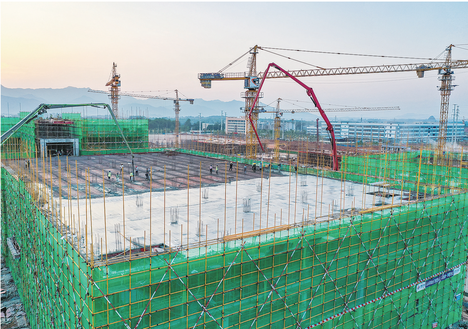
9月26日,蓝山经开区创新创业园标准厂房三期项目建设现场,工人在有序施工。近年来,蓝山县积极加强标准厂房等基础设施建设,对接粤港澳大湾区,承接皮具箱包产业转移,打造现代皮具箱包科技产业园。目前已引进皮具箱包玩具企业150余家,总投资177亿元。 彭华 摄
