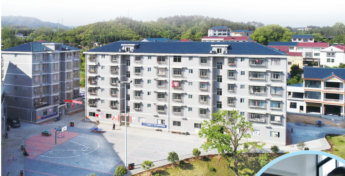
航拍洪江市太平乡集镇广场安置点。 李林 摄
