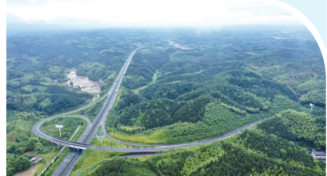
常德高速公路建设跑出“加速度”。
