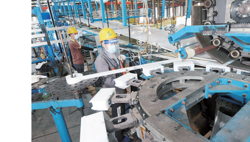
9月14日,湘潭固可得制造有限公司节能保温一体化金属幕墙生产线,生产人员在进行设备调试。公司去年引进的新生产线于今年7月投入试运行,预计年内可为公司新增营收2000余万元。 湖南日报全媒体记者 田超 摄
