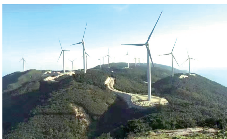
新田县五凌舍子源风电场主体土建及吊装工程施工。
