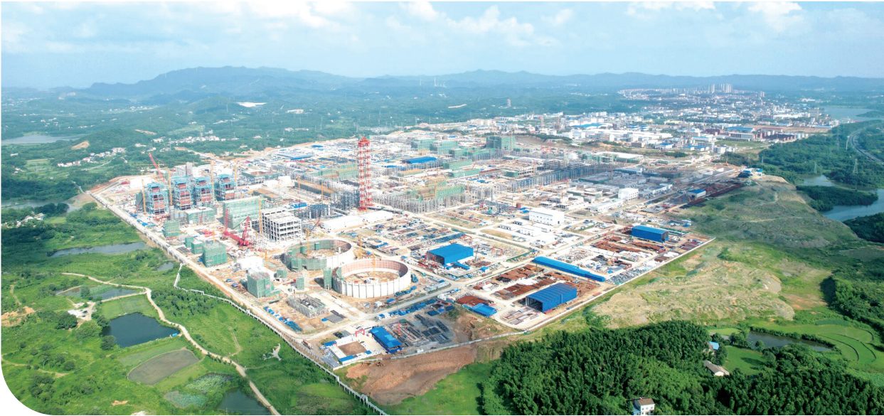
巴陵石化己内酰胺产业链搬迁与升级转型发展项目工地俯瞰。（本文图片由彭展 李翼骏 景志刚提供）
