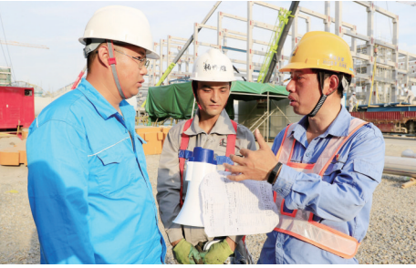
巴陵石化己内酰胺产业链搬迁与升级转型发展项目部HSE部管理人员在现场检查承包商防暑措施落实情况。
