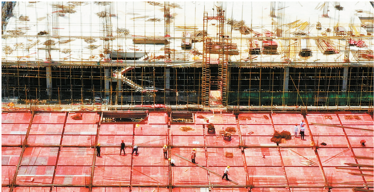
7月25日，嘉禾县新城区一项目建筑工地，工人在高温下施工。
