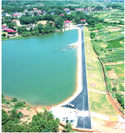
祁阳市广溪水库。（祁阳市水利局办公室供图）
