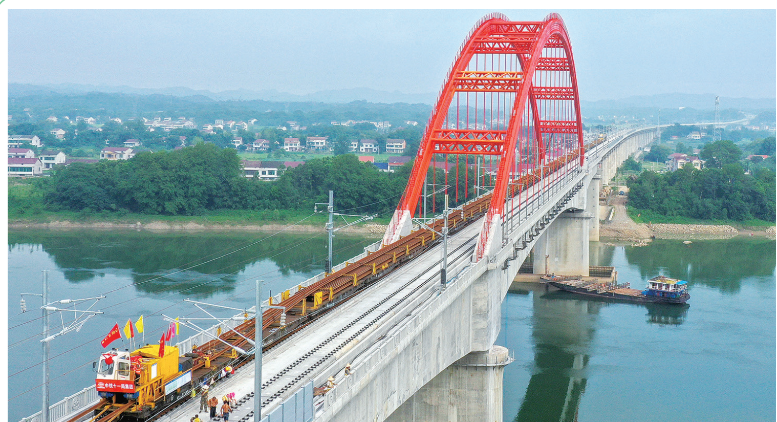
常益长铁路铺轨顺利通过资水特大桥
