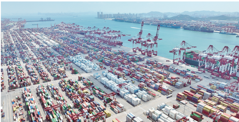
繁忙的山东港口青岛港前湾港区，集装箱货轮在装卸集装箱(6月15日摄，无人机照片)。青岛海关数据显示，今年1月至5月，青岛直达金砖国家的航线共完成箱量83万标箱，同比增长12%，其中出口量增长26.1%。
