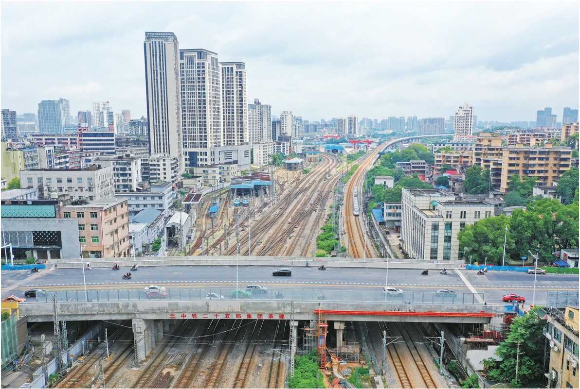
飞跨9条铁路股道 株洲新华桥通车 6月20日,由中铁二十五局承建的株洲新华桥拆除重建工程如期完工试通车。该桥长110米,采用双向8车道设计,桥梁上跨9条铁路股道,其施工相当于在全国普铁南北大动脉上“动刀子”,难度极大。通车后将提升株洲中心城区区位优势,助力长株潭一体化发展。 湖南日报全媒体记者 李健 通讯员 刘胡 摄影报道
