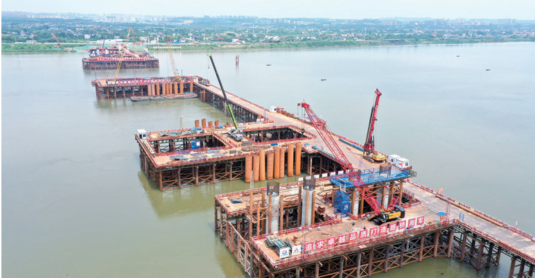
长沙交通工程项目建设持续推进。图为暮坪湘江特大桥项目建设现场如火如荼。 田超 摄
