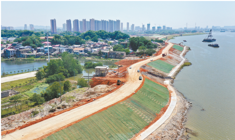
望城区湘江东岸 堤防建设有序推进
