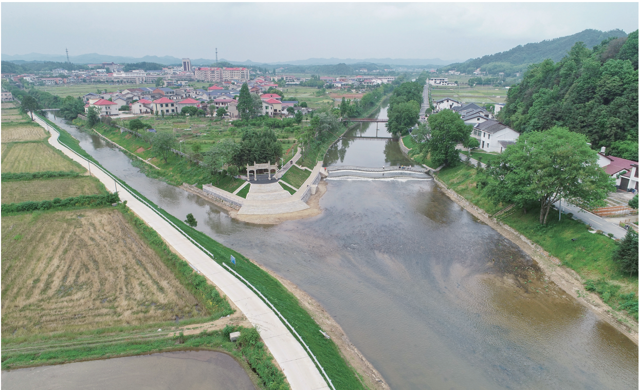
4月27日,长沙县金井镇,修葺一新的金井河两岸,水清、岸绿、景美,成为附近居民休闲打卡的新去处。近年,该县将中小河流治理、小型农田水利建设与美丽乡村建设有机结合,让农村有景看、农业有钱赚,打造了一批乡村旅游“网红打卡点”。
