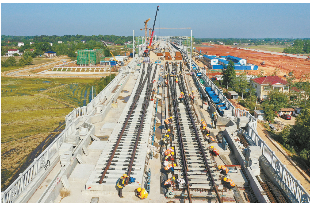
常益长高铁常益段开始铺轨
