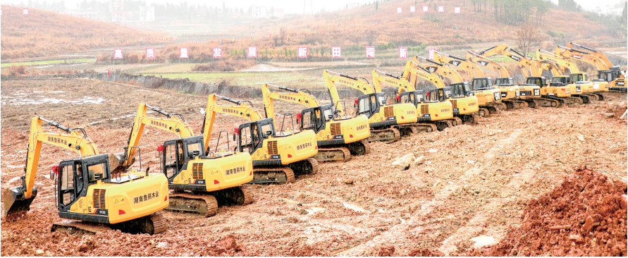
2月18日，新田县湖南鲁丽绿色新材料科技产业园项目正式开工建设。
