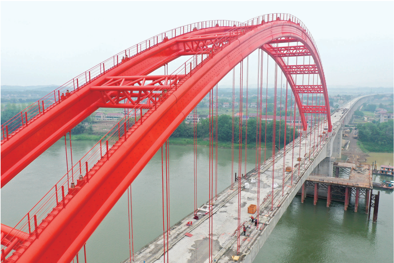
常益长高铁资水特大桥建设完工 4月15日，由中铁五局承建的常益长高铁控制性工程——资水特大桥建设竣工，为常益长高铁早日通车奠定基础。常益长高铁全长约157公里，设计时速350公里，是国家“八纵八横”高速铁路网的重要组成部分。 湖南日报全媒体记者 郭立亮 通讯员 谢永彬 摄影报道
