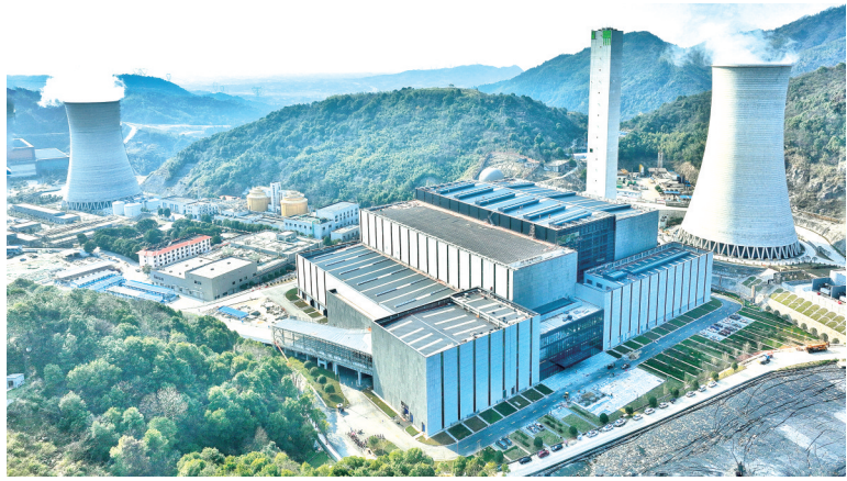
长沙市生活垃圾与市政污泥协同处置二期项目。
